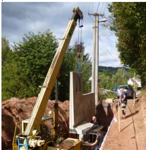
Ze stavby opěrné zdi v Hlubočkách
